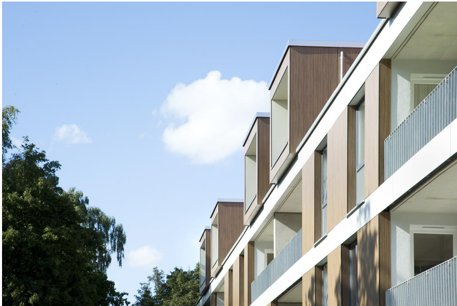
Gartenansicht nach Sanierung
