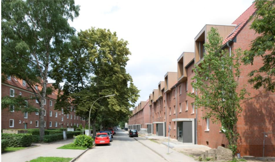
Straßenansicht nach Sanierung
