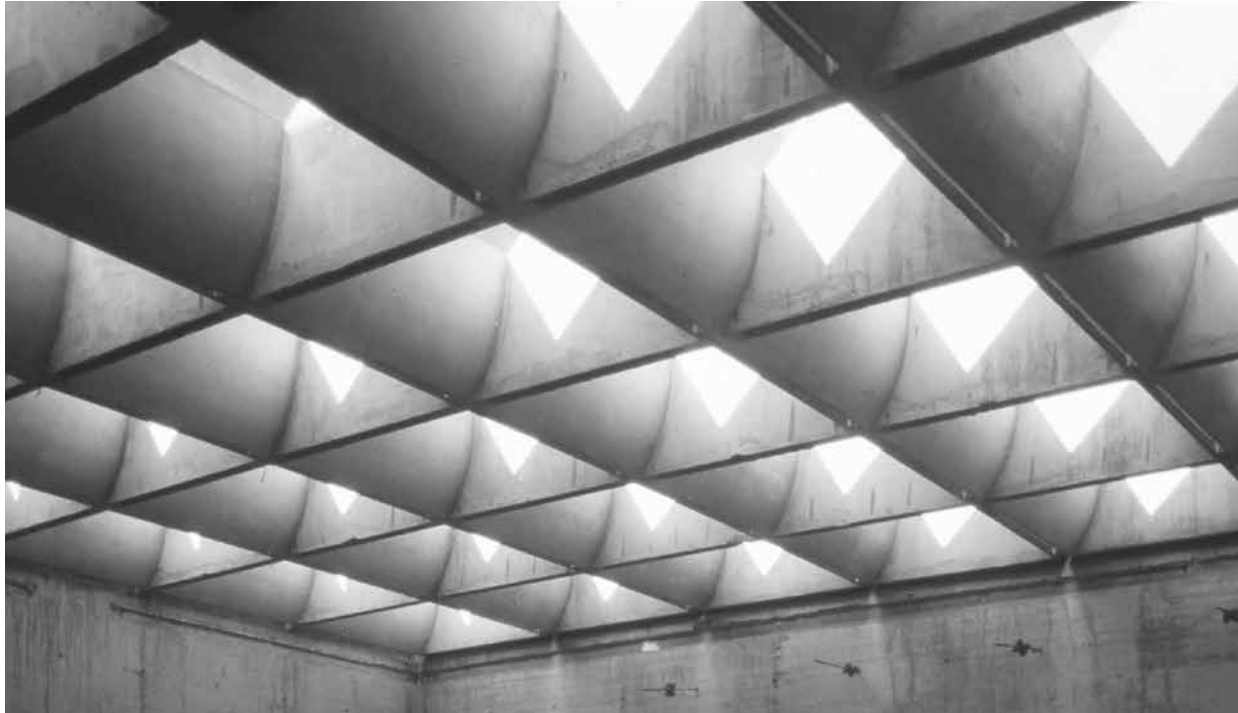
Axel Schultes in BJSS mit Jürgen Pleuser, Kunstmuseum Bonn, Lichtdecke im Rohbau, Bonn 1985–1992
