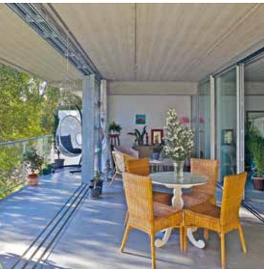
kann mittels Schiebefenstern um den Raum des Wintergartens erweitert werden. Dieser fungiert wiederum – je nach Außentemperatur – als offene Loggia oder wird durch Polycarbonat-Schiebeelemente geschlossen. Im Winter dient diese Konstellation als thermischer Puffer, ohne den Innenraum zu verschatten.
