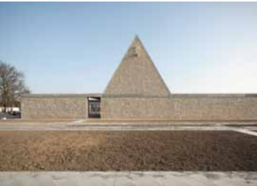
Nordfassade zum Friedhofsgarten
