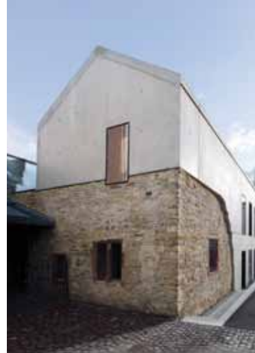
Alte Kusterwand und neues Pfarrheim
