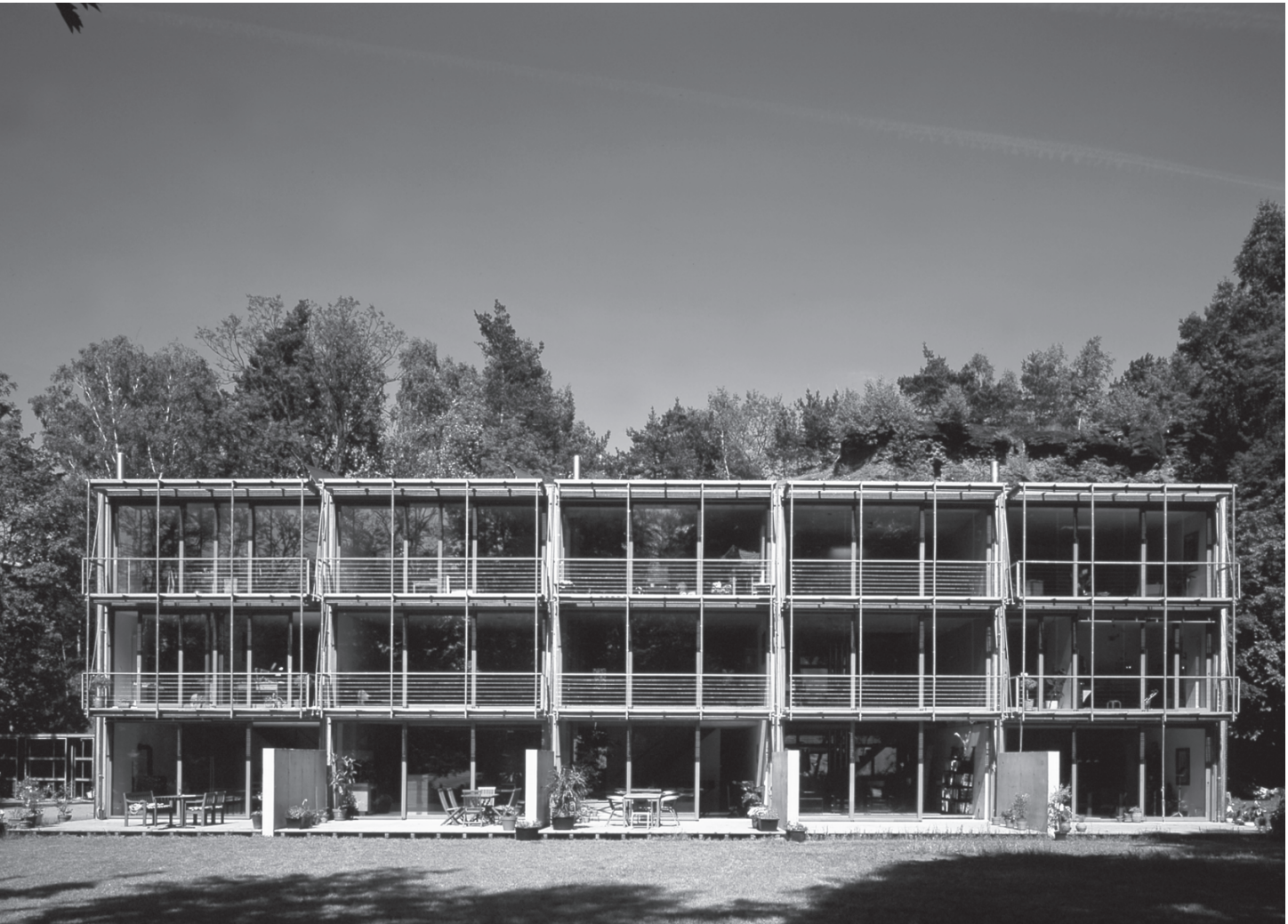
Ansicht von Süden am Tag
