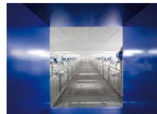
Durchgangsröhre zur Filterhalle
