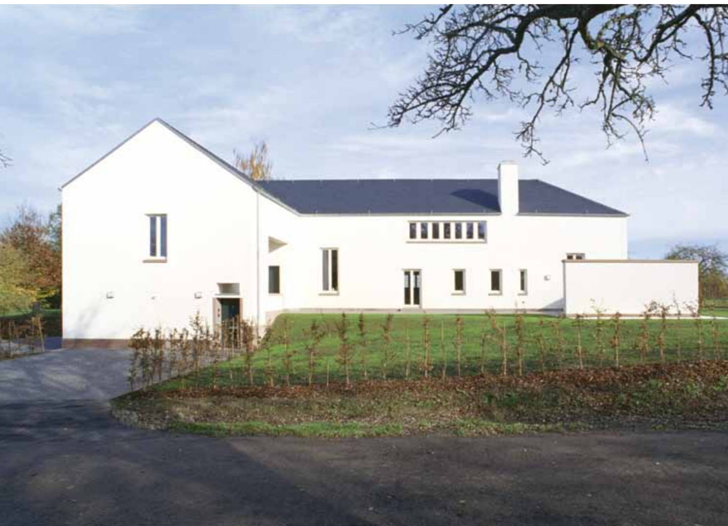
Ansicht von der Strasse
