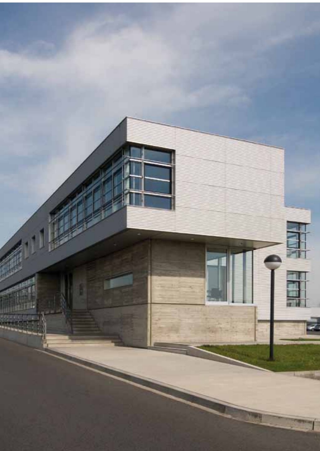
Eingangssituation von der Werkszufahrt
