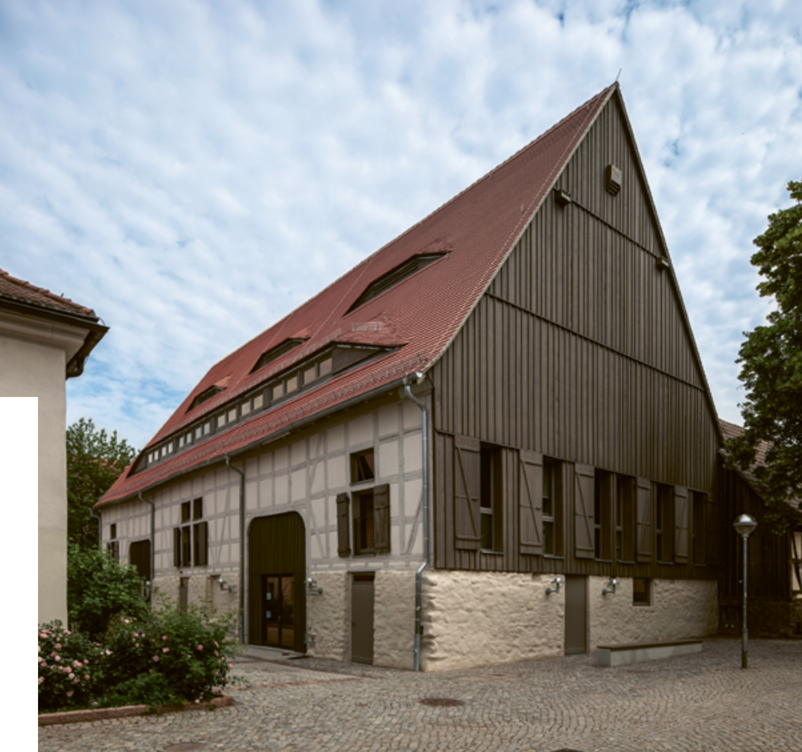
SANIERUNG/UMBAU DER HISTORISCHEN FELDSCHEUNEN 50 Frankesche Stiftungen, Halle/S.
