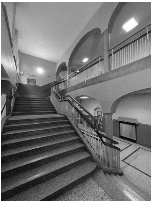
Aktueller Zustand des Treppenhauses der Kreuzschule. Foto: BDA Dortmund
